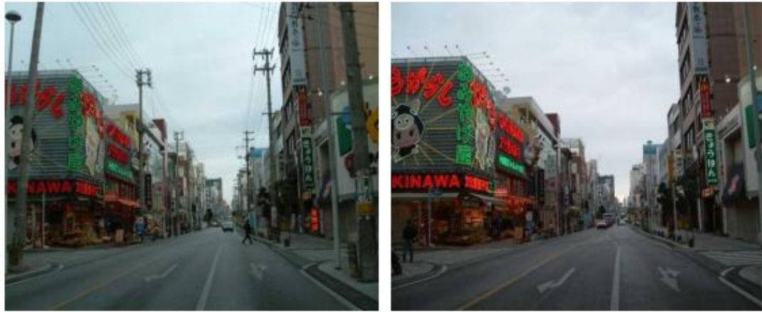
写真－2 国際通り(那覇市)の整備前後の状況(左:整備前、右:整備後) [出典:沖縄県無電柱化推進計画(令和4年3月沖縄県土木建築部)]
