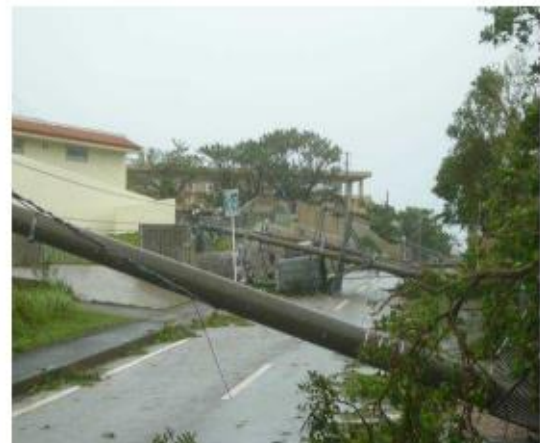
写真－1 台風による電柱倒壊状況
